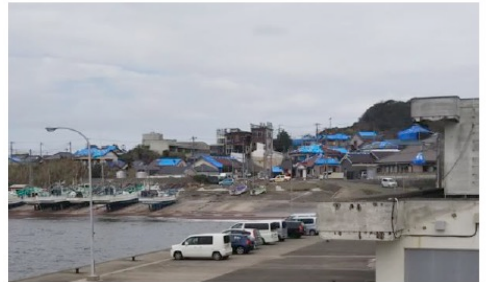
「ブルーシートで屋根を保護する家屋」 気象庁「災害時自然現象報告書 2020 年第 2 号」より
